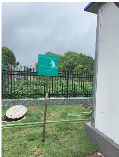
厂区污水总排口及标识牌
