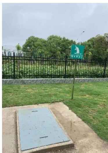
雨水排口及标识牌
